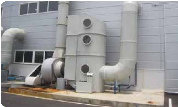
Hệ thống xử lý hơi hóa chất
